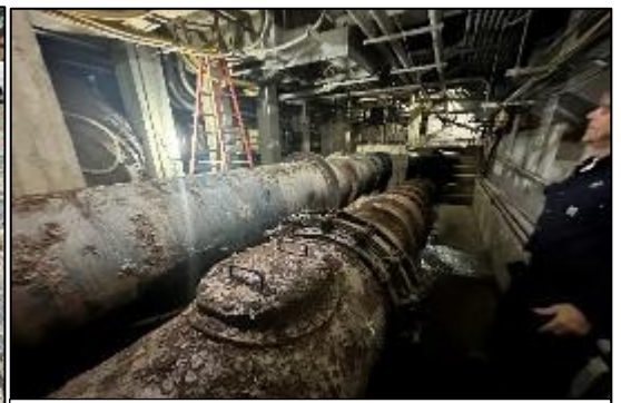
18 de noviembre - Trabajos Eléctricos - Sótano principal de PS
