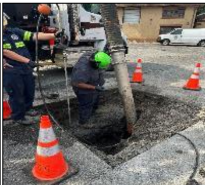
31 de julio - Equipo Excavador - Little Falls
