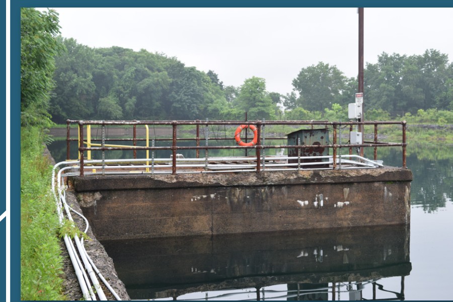
রিজার্ভারের আউটলেট চেম্বার জীবাণুমুক্তকরণ এবং গ্রাহকদের বিতরণের জন্য রিজার্ভার থেকে জল টেনে নিত। এই আউটলেট চেম্বার এবং পুরানো ক্লোরিন স্টেশন 1932-33 সালে কংক্রিট দিয়ে নির্মিত হয়েছিল, যেখানে আগে একটি পাথরের চেম্বার ছিল।
